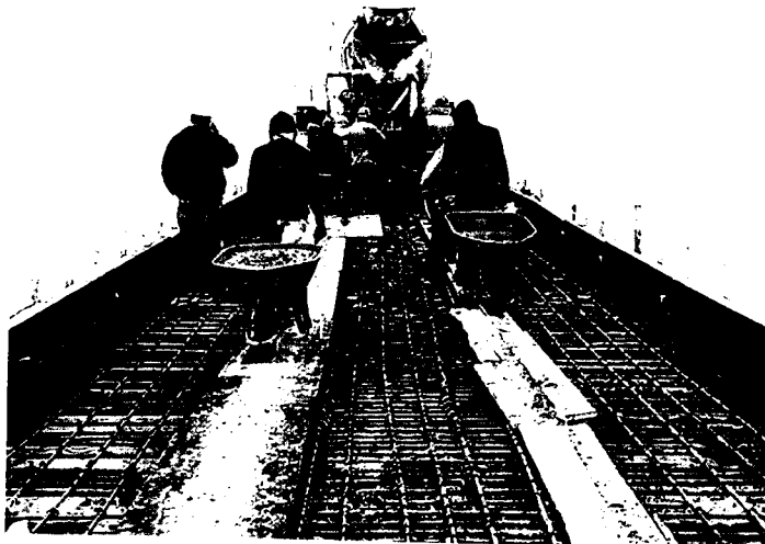
FOTO 02: Vaciado de concreto en losa del día 03/07/19
