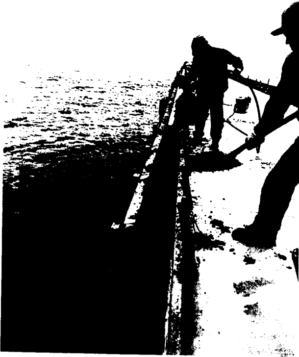
FOTO 13: Se continúa con el encofrado de sardineles
