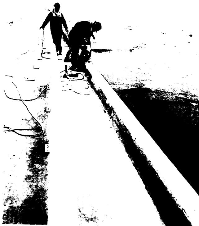
FOTO 12: Entubado y encofrado de sardinel del día 17/07/19
