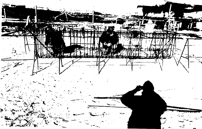
FOTO 16: Armado de viga de guardia del cabezo
